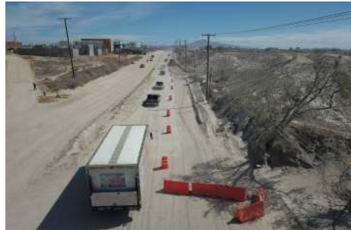
COLOCACIÓN DE SEÑALAMIENTO DE OBRA
